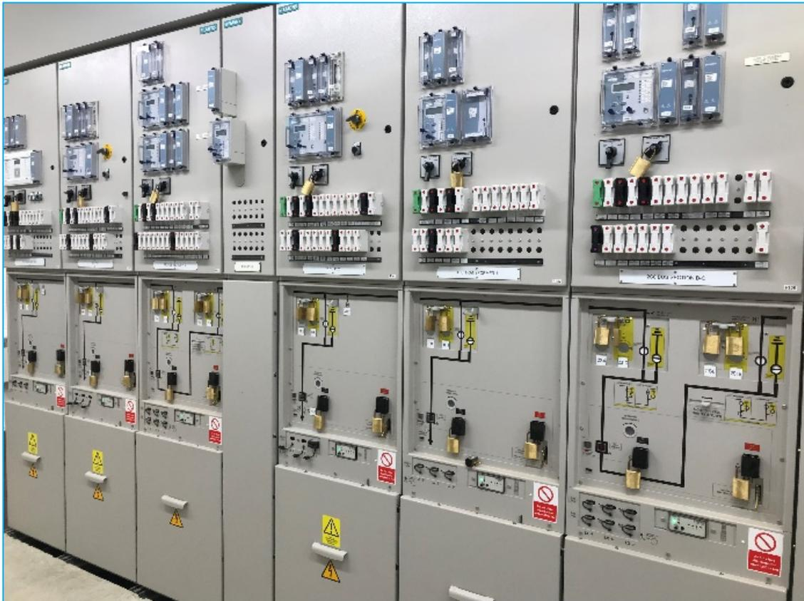
Figure 3-13: 33kV Switchgear
